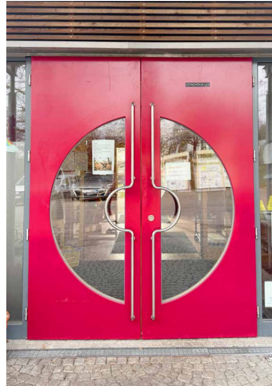
Eingangstüre des Kinderhauses Maria am Wege mit elektrischem Türöffnungssystem
