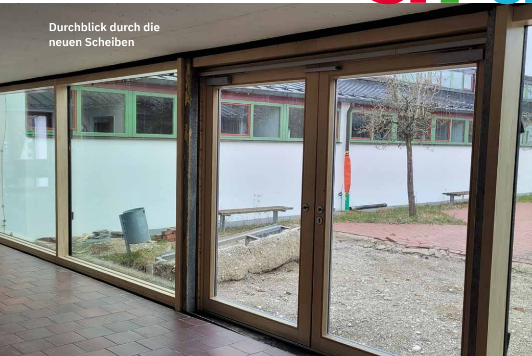
Türflucht im sanierten Trakt
