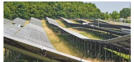
Der Solarpark Breitenmoos an der A96
